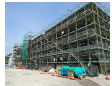
工事が進む第二江津中央団地
