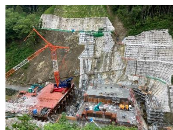
供用開始を目指し 工事が進む波積ダム
