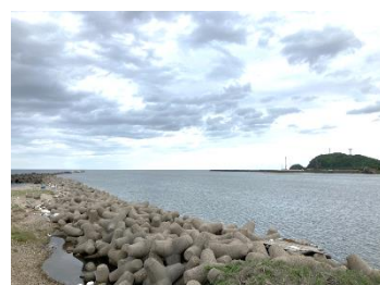
航路の浚渫などが 予定される江津港
